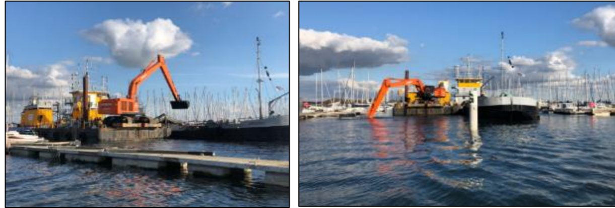
FIGURE 10 : DRAGAGE MECANIQUE PAR PELLE (SOURCE : MERCERON TP, 2020)
