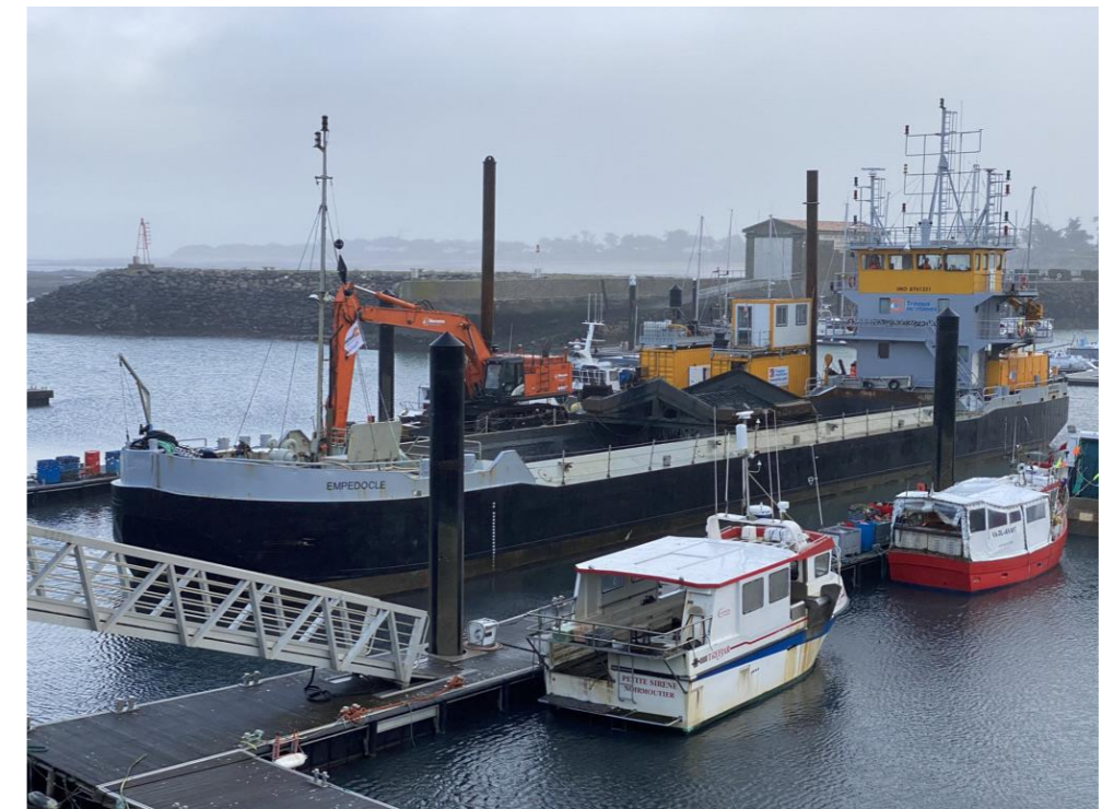
FIGURE 14 : CHARGEMENT PAR PELLE MECANIQUE D'UNE BARGE AUTOPORTEE APPARTENANT A LA SOCIETE MERCERON
